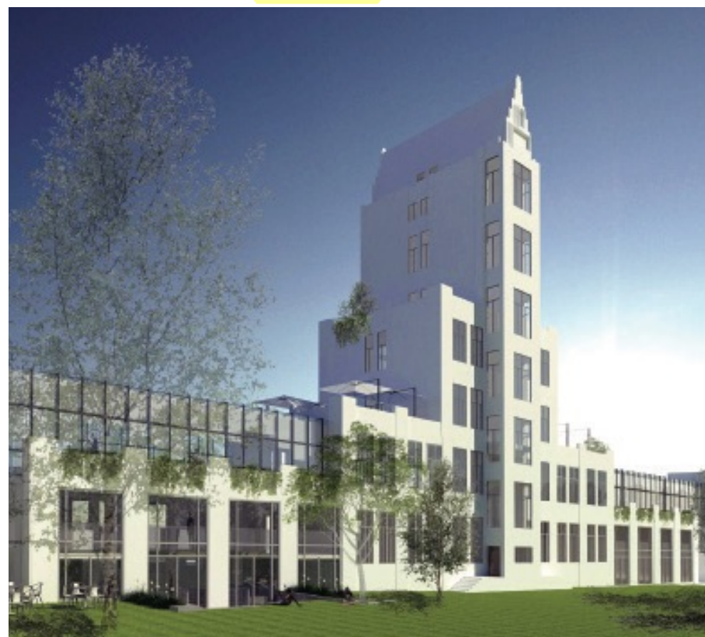
Vue et perspective du bâtiment après sa rénovation.
