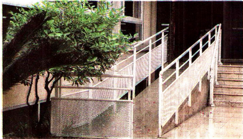
Les rampes d'accès, structures indispensables pour les bâtiments universitaires.
