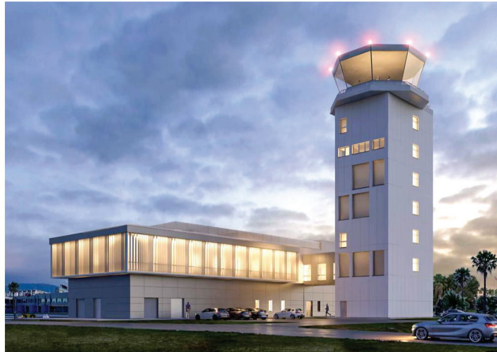
La tour de contrôle de l'aéroport de Port-au-Prince à Haïti accuse 32 mètres de haut.
