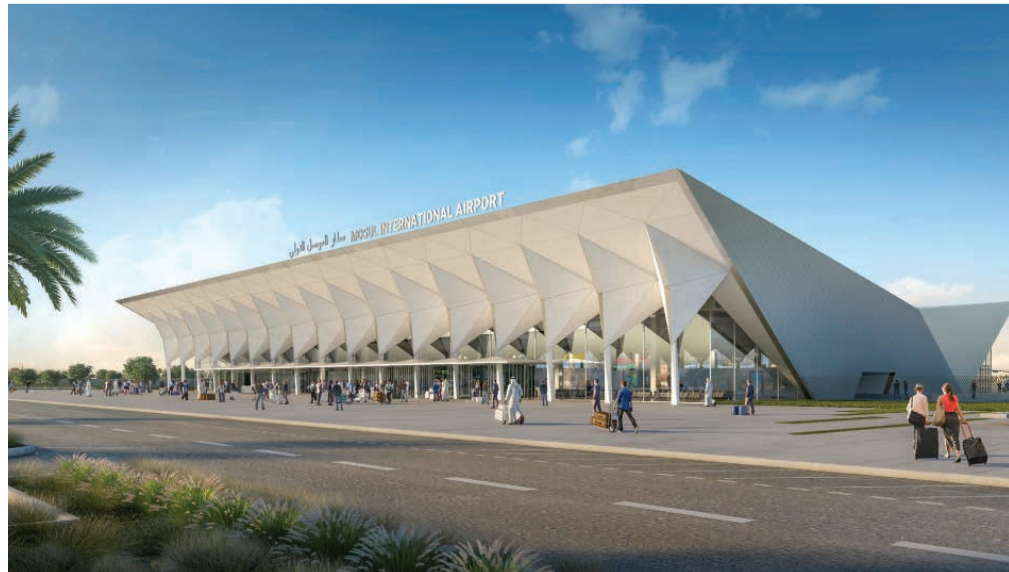
Le terminal de l'aéroport de Mossoul, un projet pour 550 000 passagers par an qui s'étale sur 6 000 m 2 .
