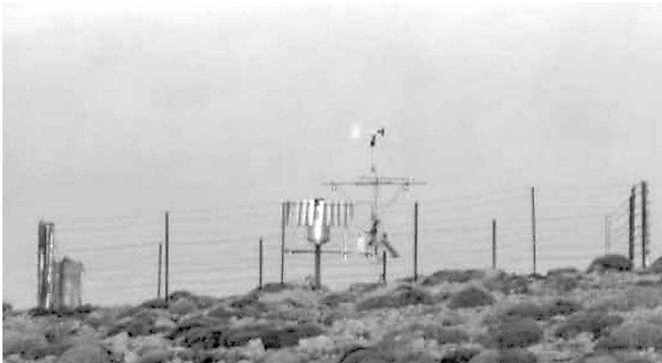
La station le jour de son installation le 10 décembre.
